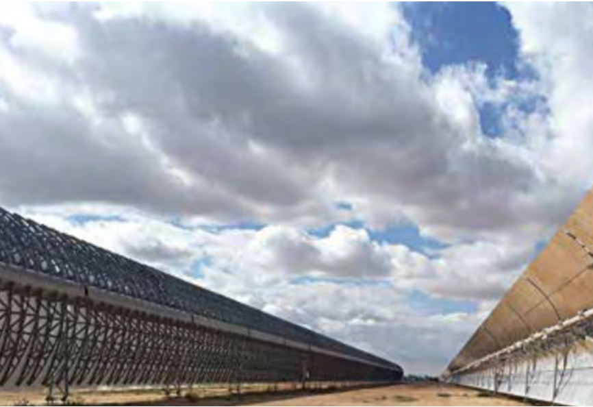
Una de las instalaciones realizadas por la empresa. // NorInver
