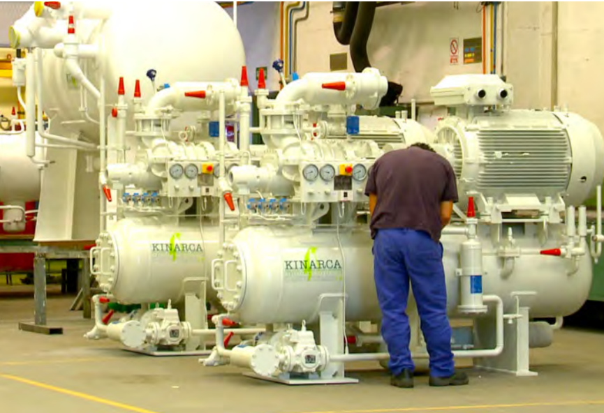
Un operario de Kinarca trabaja en uno de sus sistemas de refrigeración. // Kinarca
