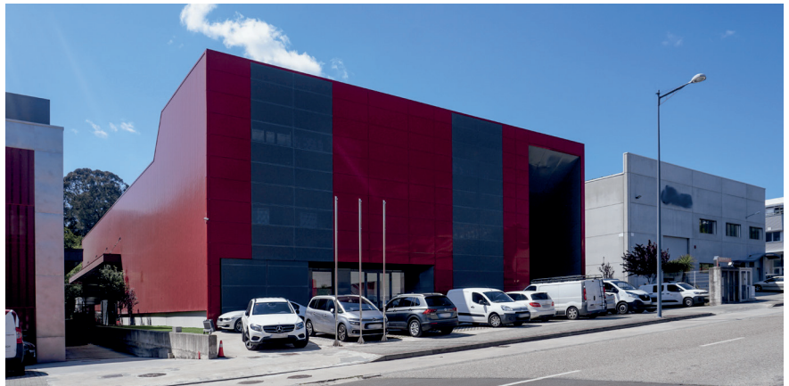
Sede de las instalaciones de Gaictech.
